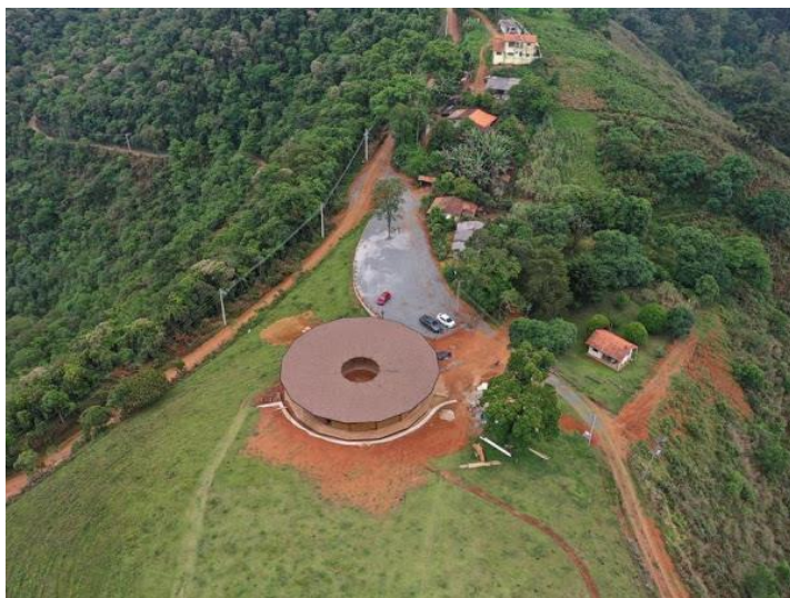
Foto: Vista aérea da estrutura do Mirante Pedra de São Francisco
