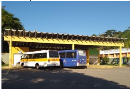
Quadro 5: Transporte Rodoviário
