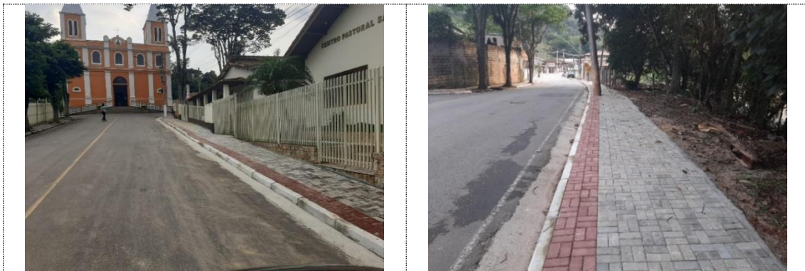
Fotos 13: Revitalização das Calçadas – Fase I – PMML/DADETUR 2022.
